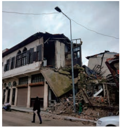
大地震から1年後も壊れたまま放置された建物＝2024年1月31日、トルコ南部アンタキヤ（筆者撮影）
