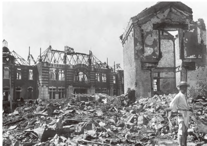
屋根が焼け落ち外壁だけ残った新橋駅(現在の汐留口)
