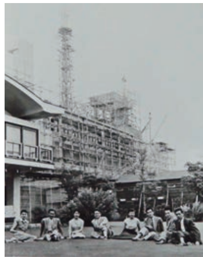
建設中のOTV(朝日放送提供)
