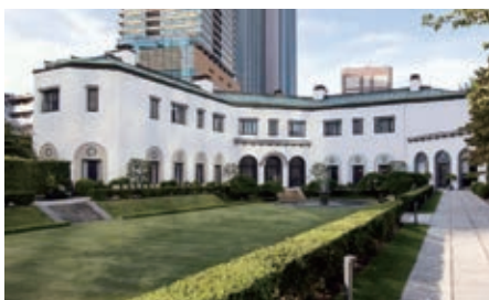
(写真3) 現在の米大使公邸。左手前の先端部一階に天皇とマッカーサーが会見したりリビングルームがある。右手、屋根の後方に少し見える建物が大使館=2017年9月（米国大使館提供）
