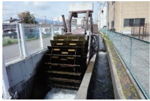
災害時に期待が強まる小水力発電施設 (長泉町、2019年3月、筆者撮影)
