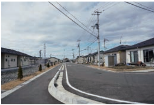
東松島市スマート防災エコタウンの街並み (東松島市、2018年3月、筆者撮影)
