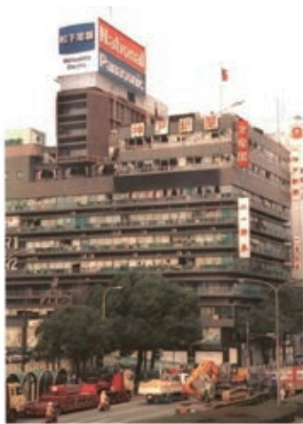
震災直後の神戸新聞社ビル。震災直後の神戸新聞社ビル。震災直後の神戸新聞社ビル。
