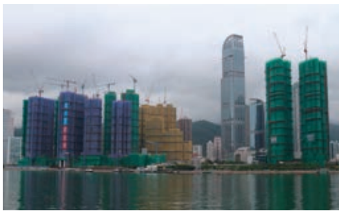
香港・新界地区で建設が進む高層住宅群 (2017年6月18日、筆者撮影)
